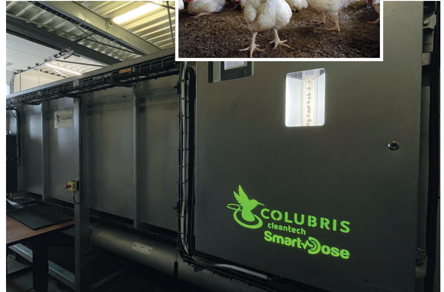
↑ Bij de zuivering in Goor automatiseert en optimaliseert SmartDose de dosering van coagulant in de waterzuivering.
