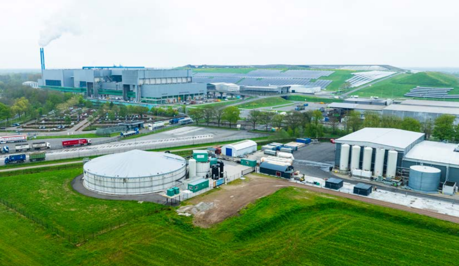
Die Kläranlage mit der Verarbeitungsanlage von Noblesse Proteins auf der rechten Seite.
